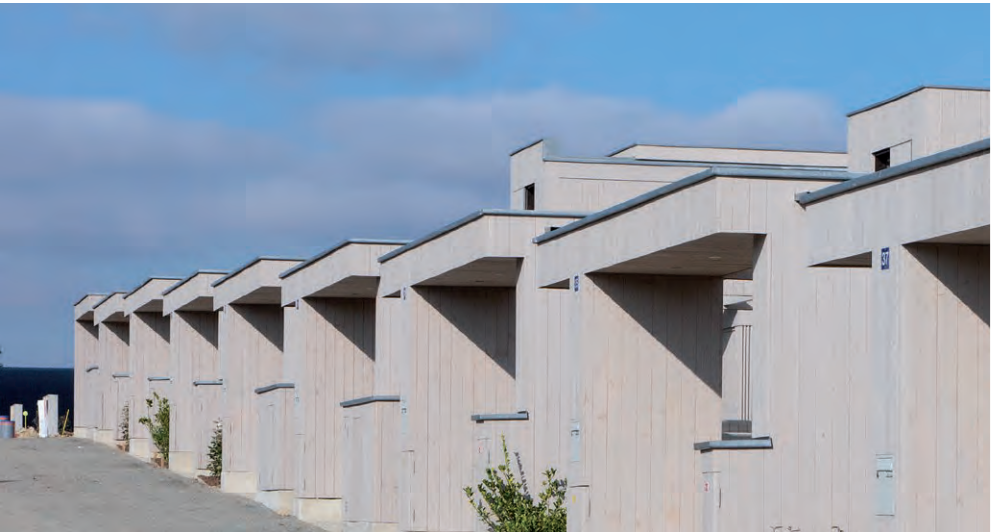
Architectes : Jean et Aline Harari – Photo : Antoine Mercusot.
