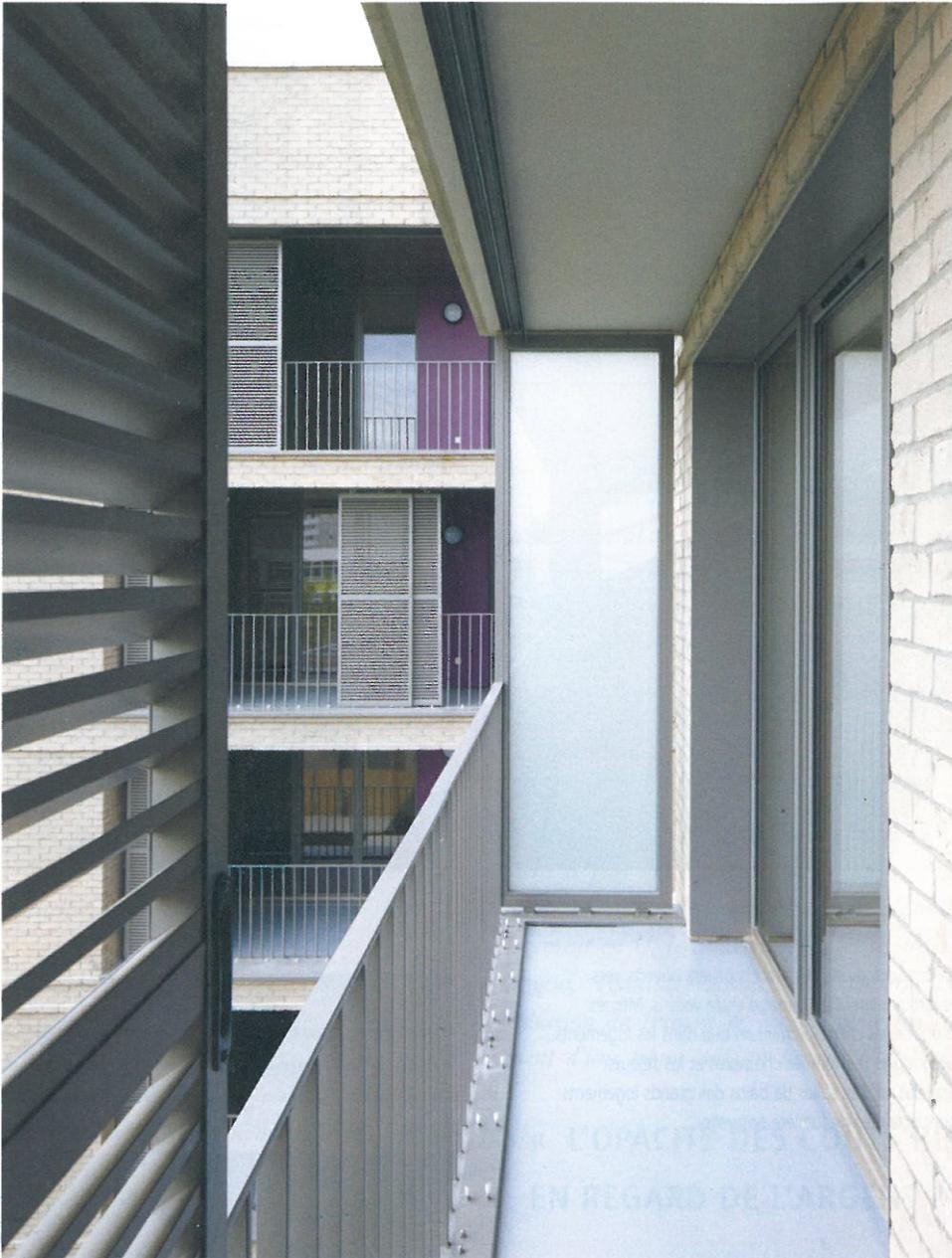
Les persiennes coulissent devant les loggias profondes par où les pièces du logement communiquent. Les descentes d'eaux pluviales sont insérées dans le parement de brique pleine qui habille des façades devant l'isolant extérieur.
